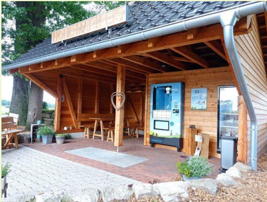
Abb.: Milchtankstelle mit Direktvermarktung im Westmünsterland
