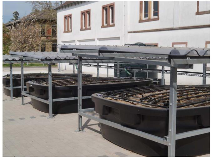
Füll- und Waschplatz für Pflanzenschutzgeräte: In Erdbehältern werden die Pflanzenschutzmittel abgebaut.
